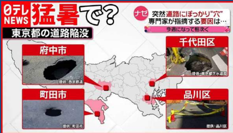
暑さによる東京都内の道路陥没(2022年6月30日) https://www.youtube.com/watch?v=eQ7zIWfSzEg (2024年2月16日確認)
